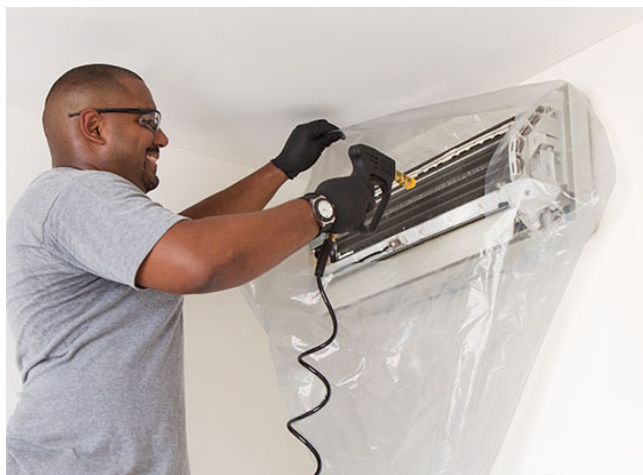
Nettoyage unité intérieure avec protection SPLIT-BAG (en option)
